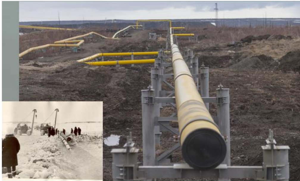
Рисунок 4. Газопровод «Мессояха-Норильск»: 1969 и 2021 (фото с сайта Газпрома)
